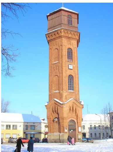
Водонапорная башня центрального водоснабжения Россия, Старая Русса, конец XIX—начало XX в.
