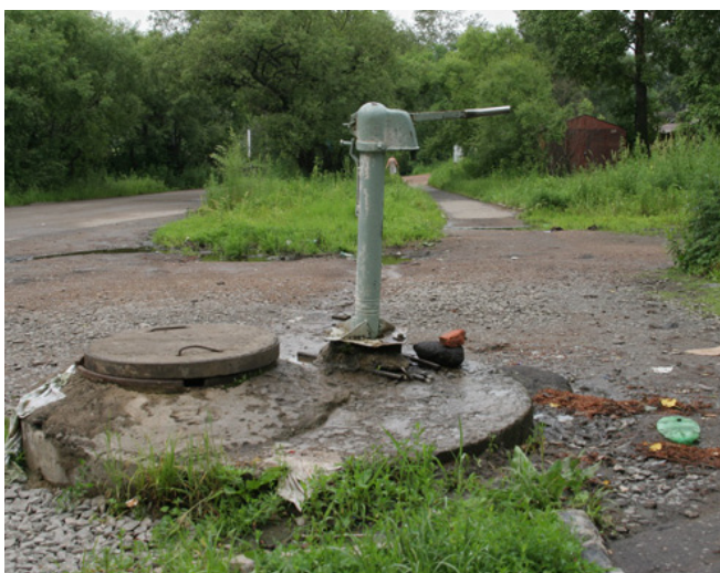
Типичная уличная чугунная водоразборная колонка первой половины XX в. (рядом видна крышка люка канализации) Россия
